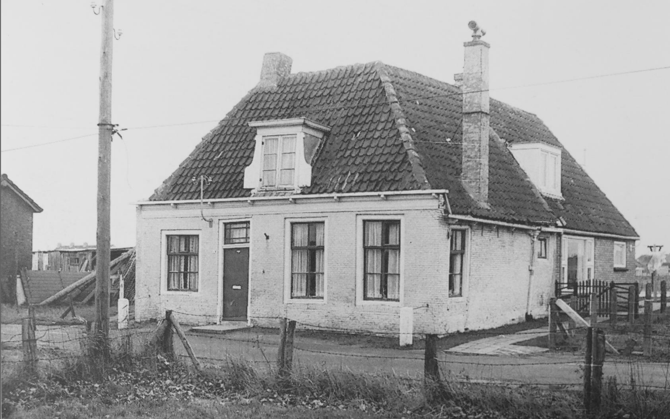
De achterste helft van deze destijds dubbele woning was tot 1966 van mijn oom Klaas de Bruin. Hij was bedrijfsleider van de Kalkovens op de vorige bladzijden.
